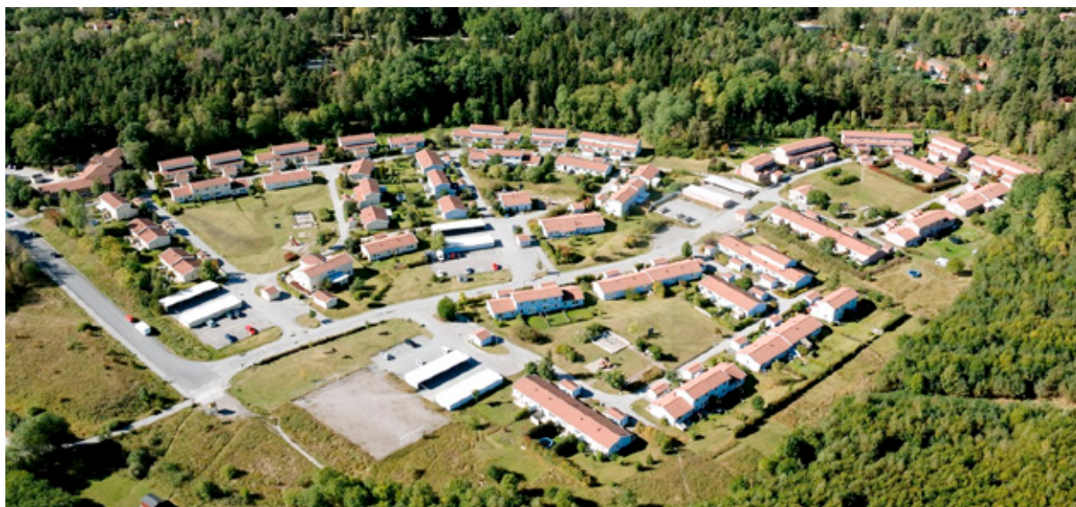
Söderströms väg, Stenhamra.
